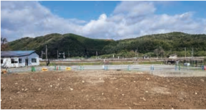
【建設予定地全景】
